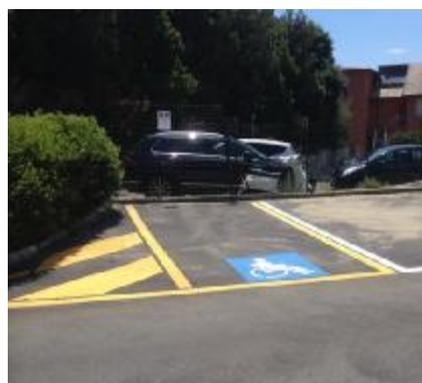
Asfaltatura strade: anche in questo esercizio sono stati effettuati interventi puntuali di riasfaltatura al fine di garantire la migliore conservazione del manto stradale esistente procedendo con fresatura della pavimentazione bituminosa esistente e stesura di nuovo tappeto d'usura asfaltico in particolare in Via della Pineta e Via del Mare, accompagnando le opere con interventi di livellamento in quota di diversi tombini nel tempo sprofondati.
